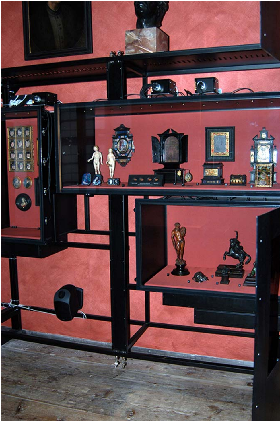
Abb. 19 Nach dem Öffnen der Vorderfront zeigt sich die Vitrinenstruktur. Die Lichtprojektoren befinden sich außerhalb der Vitrinenmodule. Darüber liegen in der Verkleidung Luftschlitze. Dies ist nicht optimal, da die Abwärme so in den Raum geht. Aber die zuerst angedachte Lösung, die Projektoren in der Technikwand unterzubringen wurde verworfen, da die Lichtleiter viel zu lang gewesen wären (teuer und Verlust der Lichtleistung)
