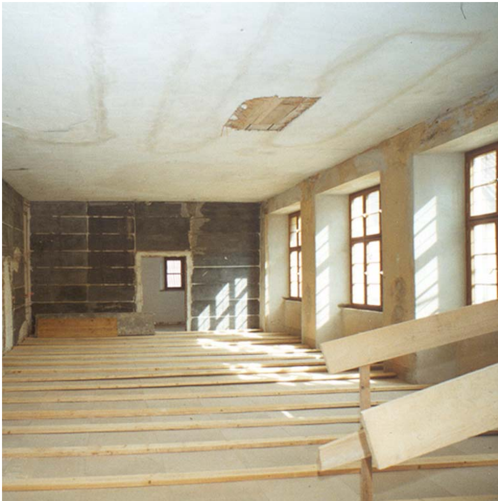
Abb. 8 Nach Einbau des neuen Unterbodens
