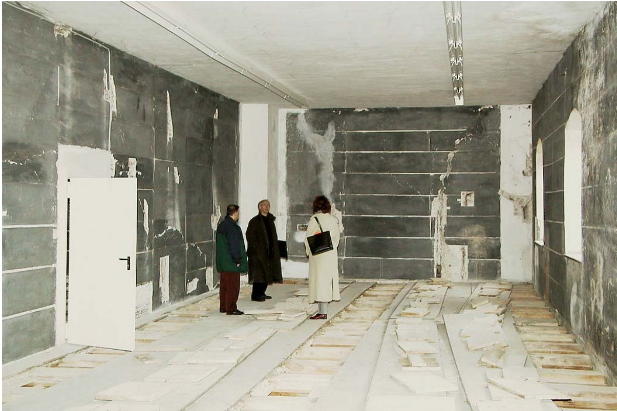
Abb. 7 Unsanierter Saal im 2.Obergeschoss
