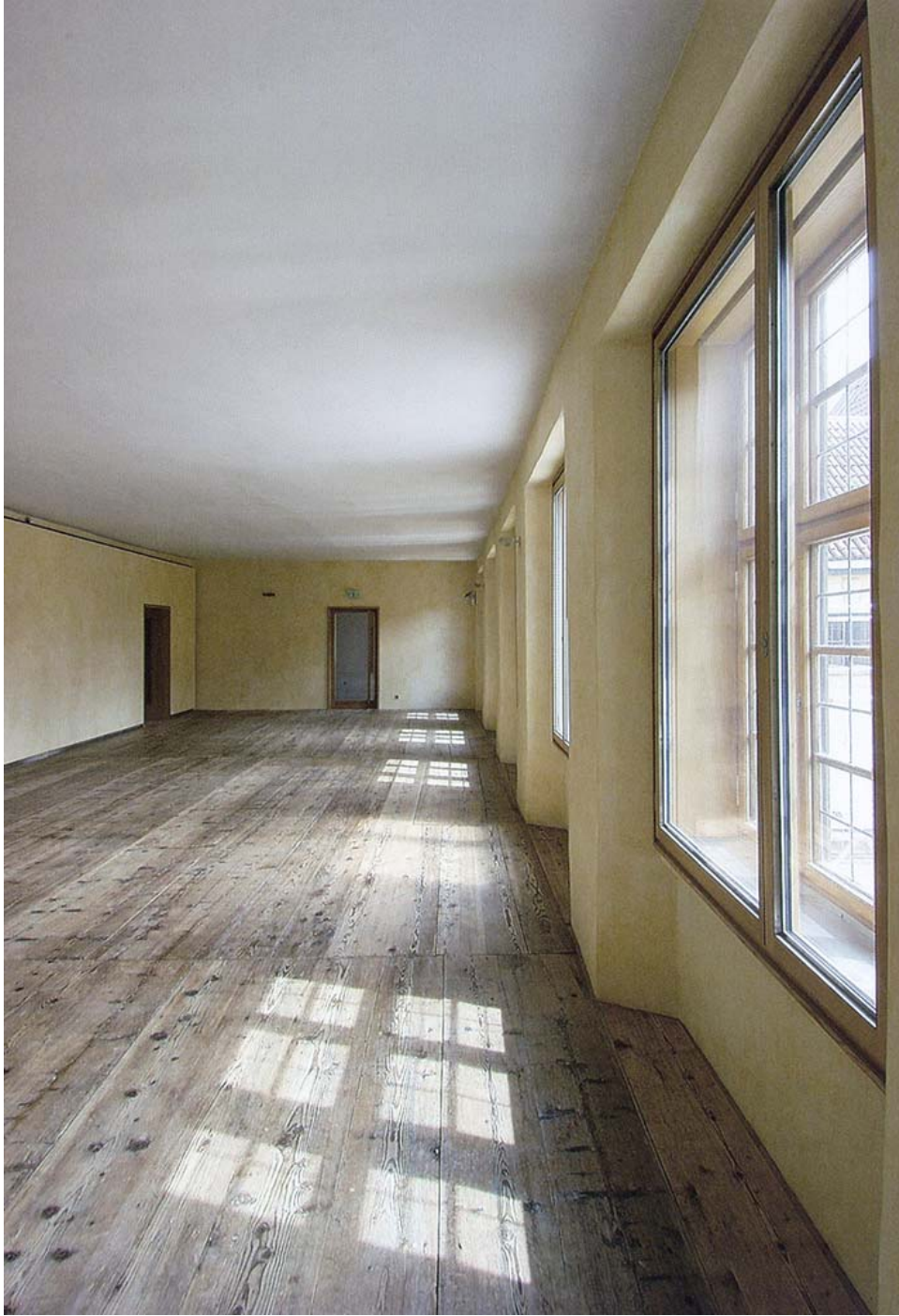
Abb. 10 Nach der Sanierung
