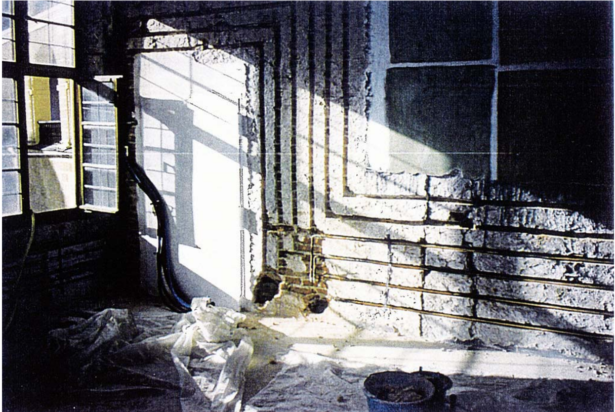
Abb.13 ausgeführter Rohrverlauf (in originaler Bausubstanz)
