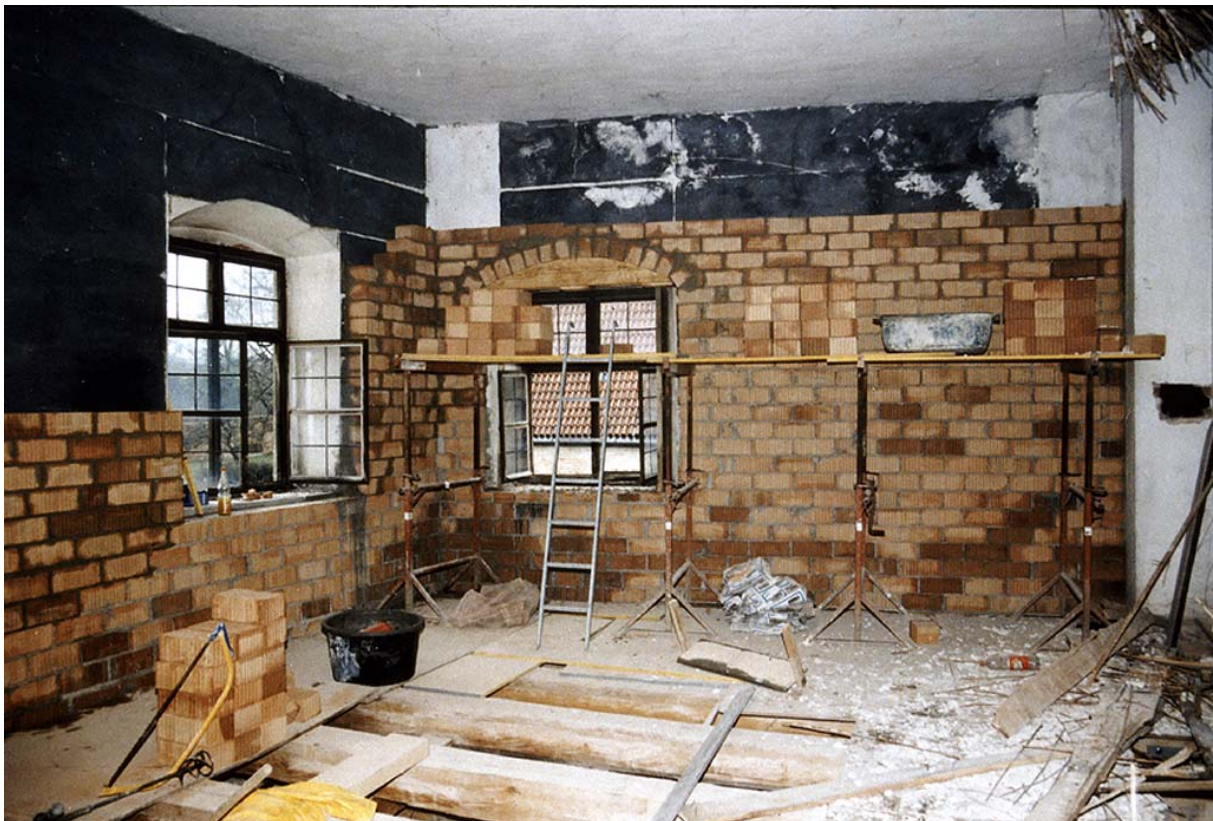
Abb.11 Aufdoppelung der Außenwände (NO und SO)
