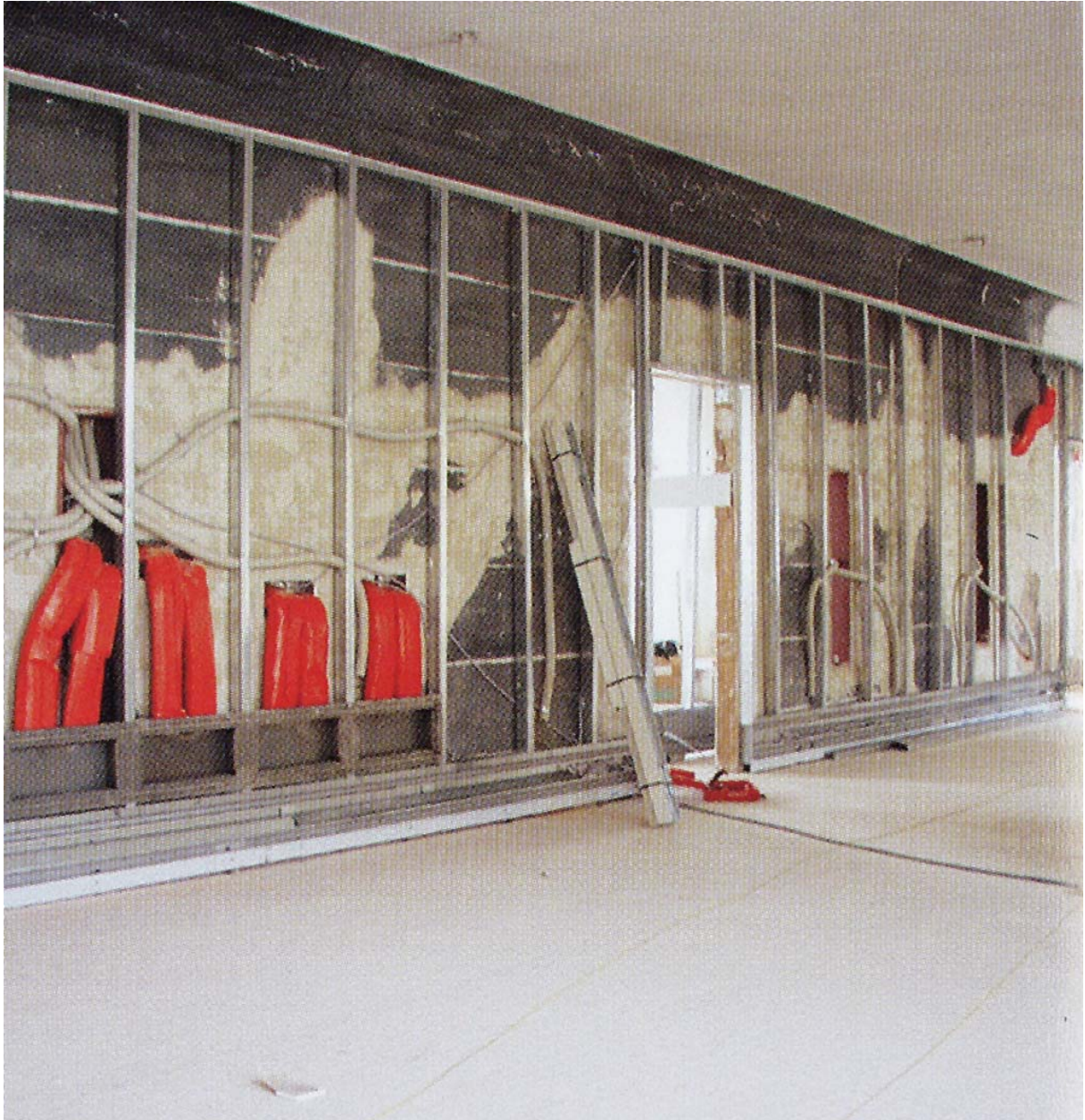
Abb. 16 Installationswand
