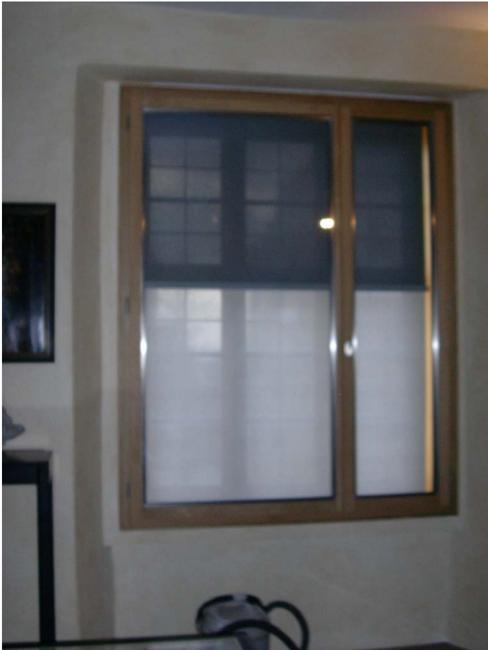
Abb. 9 Saniertes Fenster mit Lichtschutzbehängen
